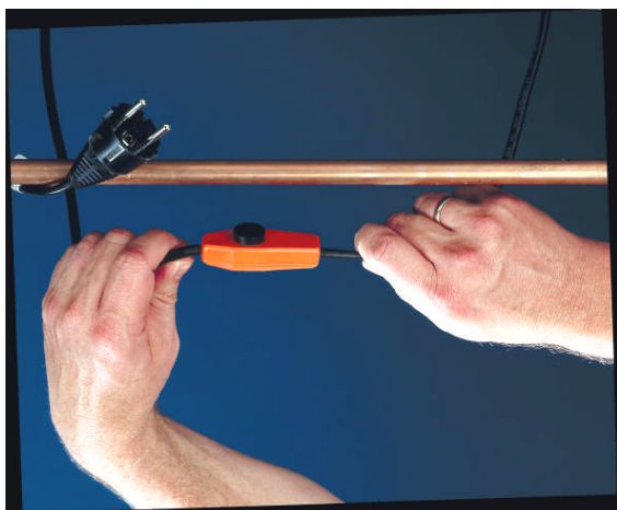
Etap 1: Umieścić termostaat na chłodniejszym z końców zabezpieczanej rury.
